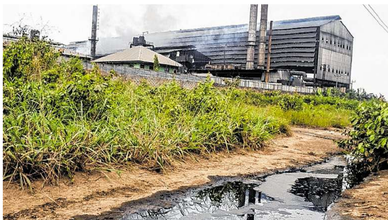
Abwasser vor der Bleigewinnung von Everest Recycling Nigeria Limited in Ipetoro.
